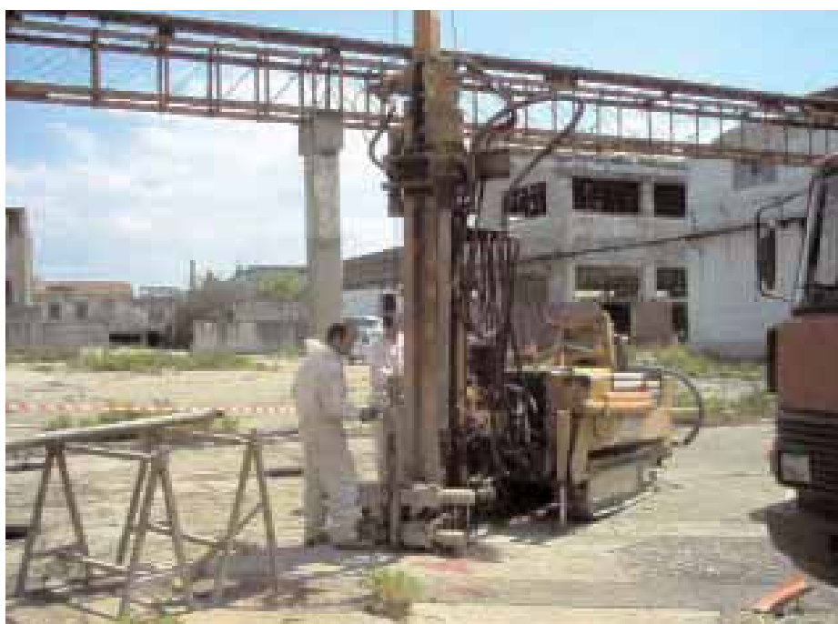
Figura 2.15 - Trivella montata su cingoli
