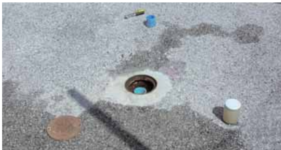
Figura 3.21 - Sigillatura superficiale e tubo protettivo di un pozzo di monitoraggio
