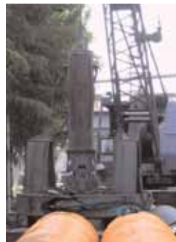
Figura 3.4 - Esecuzione di un pozzo con avanzamento a distruzione di nucleo
