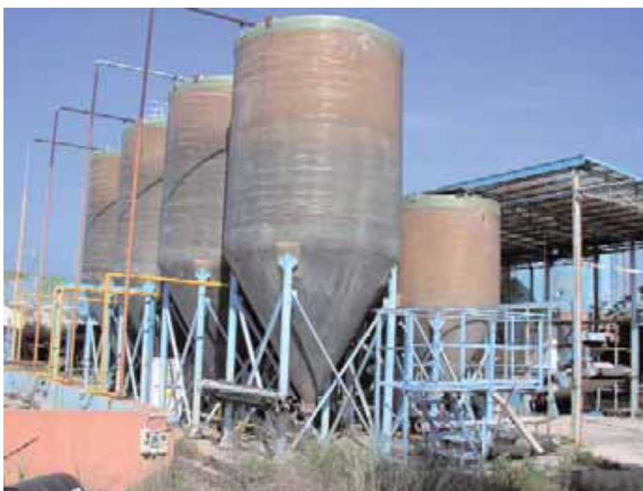
Figura 9.7 - All'interno di un sito industriale si possono riconoscere, ad esempio, settori in cui sono presenti serbatoi interrati, trasformatori, officine meccaniche, vasche di disoleazione, aree di stoccaggio fusti e/o rifiuti, in corrispondenza dei quali collocare o infittire le indagini da compiere nel sito
