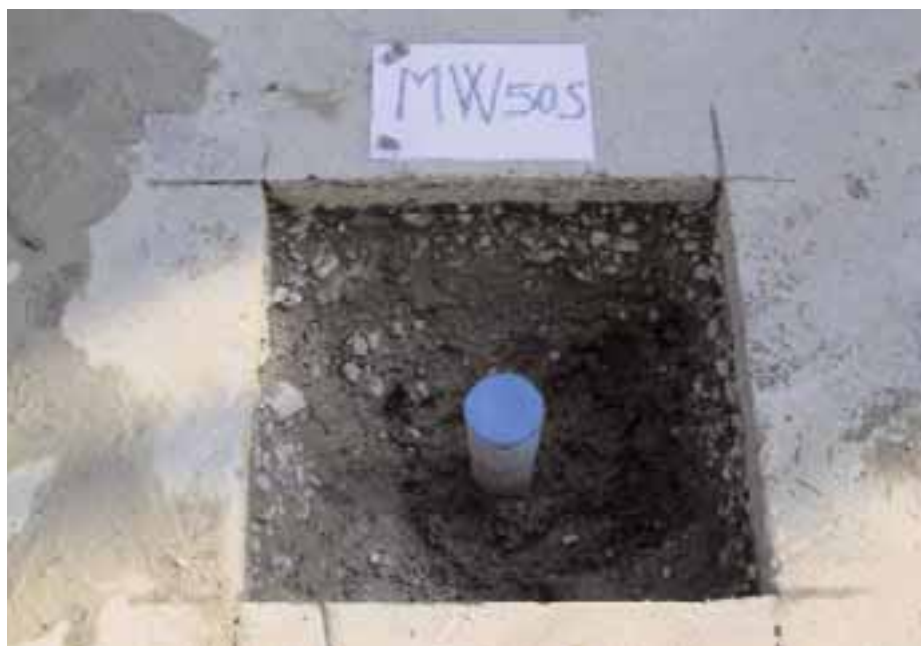
Figura 3.16 - Sigillatura superficiale di un piezometro di monitoraggio: è visibile la sigillatura finale con cemento e la predisposizione dello scavo per il pozzetto carrabile prefabbricato
