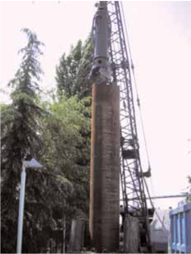
Figura 2.12 - Sistema di percussione a cavo. Nella foto è visibile la sonda all'atto dell'immissione nel tubo di rivestimento ( L = 6 \text{ m} , \Phi = 1 \text{ m} ). Quest'ultimo è manovrato da una gigantesca morsa detta giratubi che, con lenti movimenti semicircolari alternati, ne provoca l'avanzamento nel terreno di pari passo con l'azione di scavo della sonda
